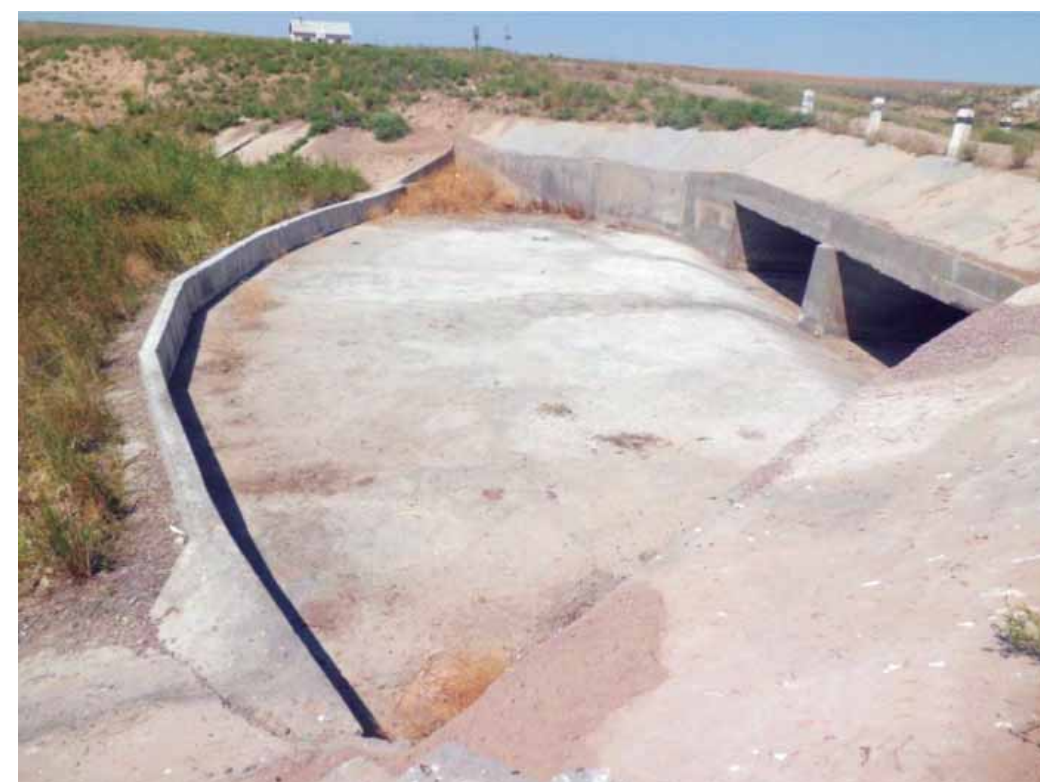
Верхний бьеф автоматического водосбросного тракта Таттинского водохранилища в реку Курагаты
