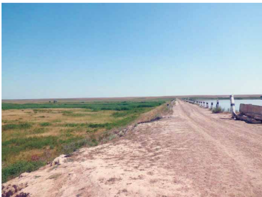
Земляная плотина Таттинского водохранилища
