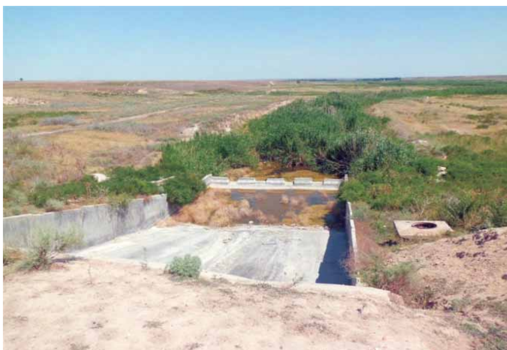
Нижний бьеф автоматического водосбросного тракта Таттинского водохранилища в реку Курагаты
