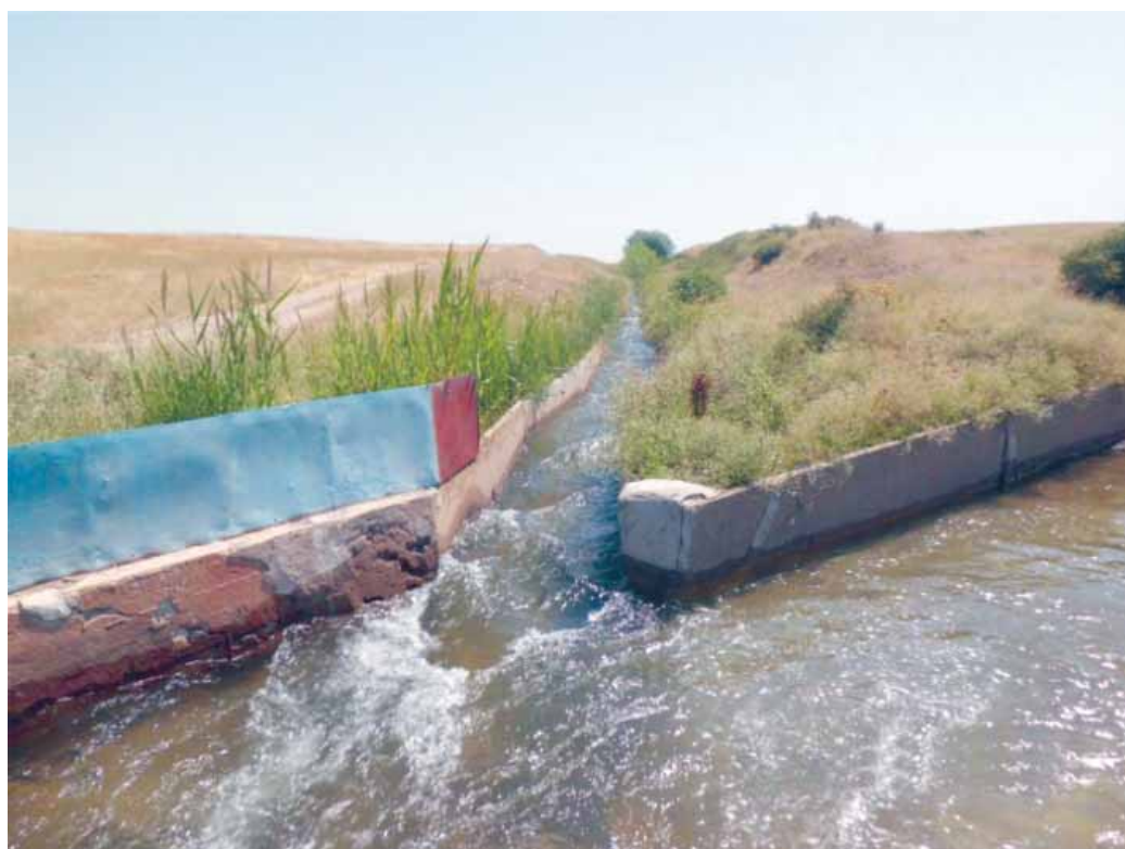
Гидроузел на МК Майлибай
