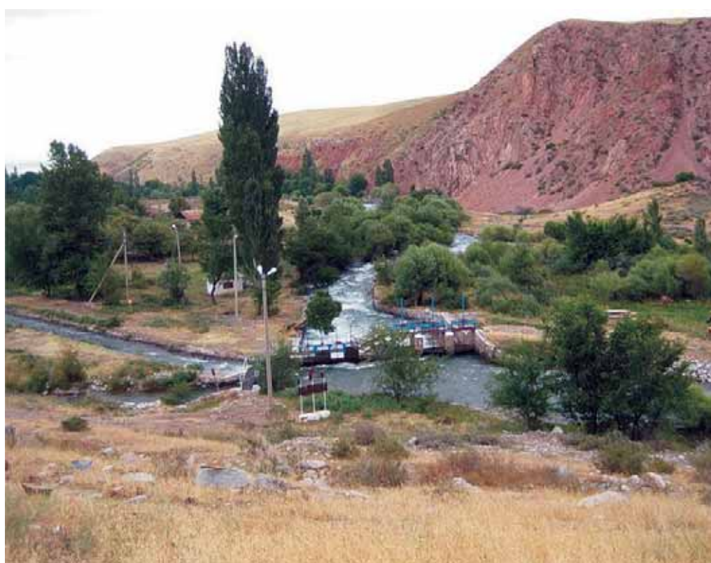
Распределительный гидроузел возле Гранитогорстка
