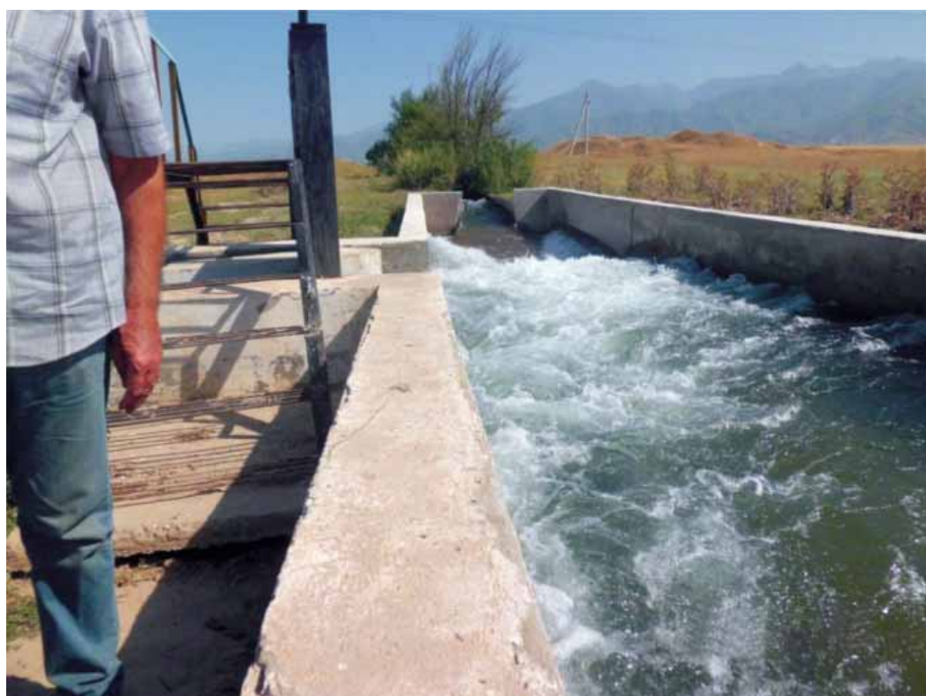
Водораспределительное сооружение на Аспаринском подпитывающем тракте
